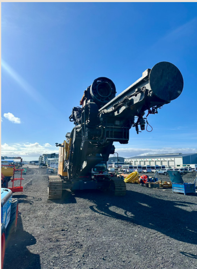
Tækið sem rekur staurana niður í holurnar sem verið er að bora.
