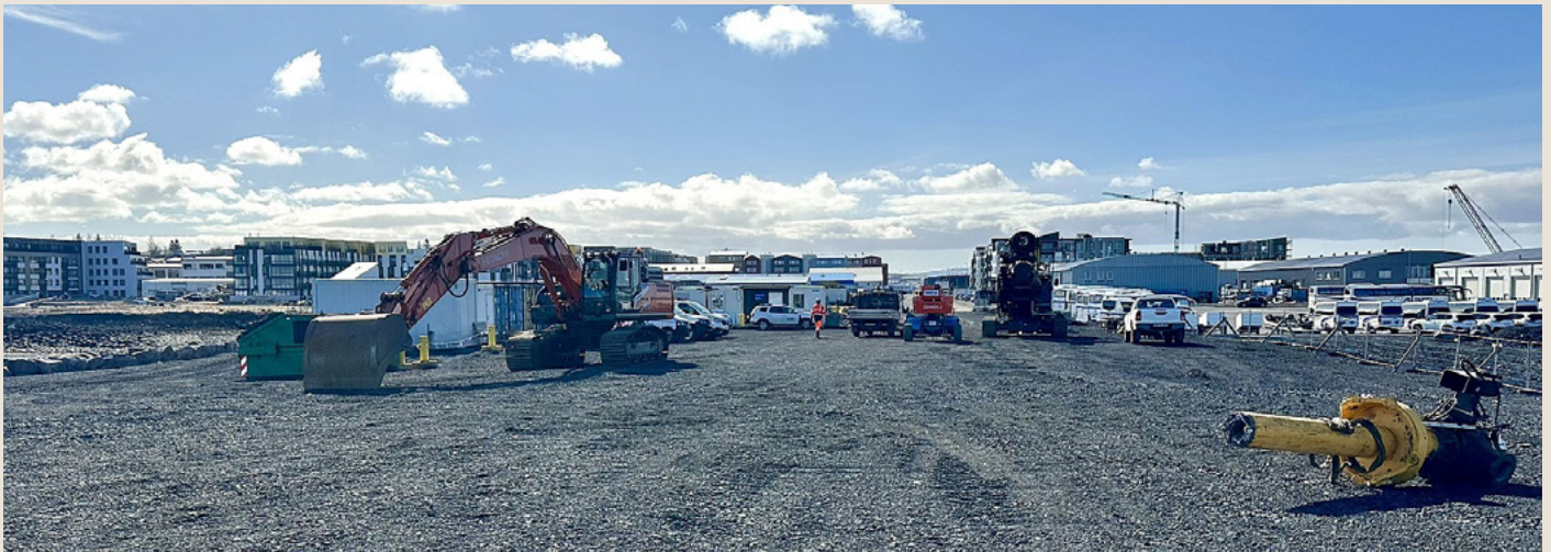
Framkvæmdir við Fossvogsbrú á Kársnesi í Kópavogi. Landfyllingin var afhent verktökum í janúar.
