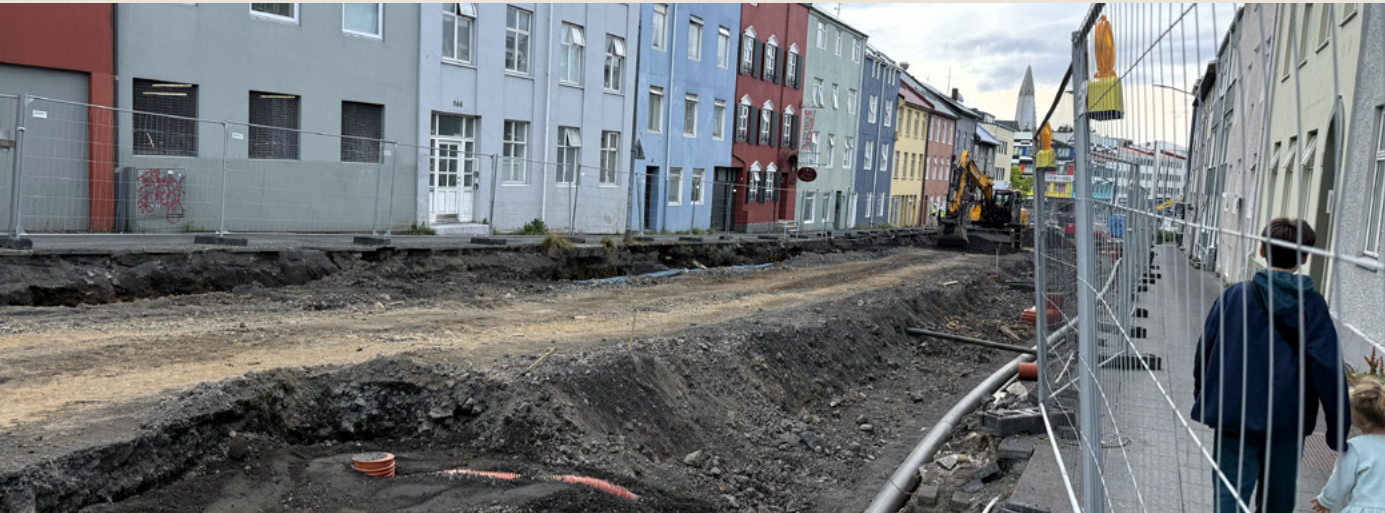
Framkvæmdasvæðið við Laugaveg um miðjan ágúst.
