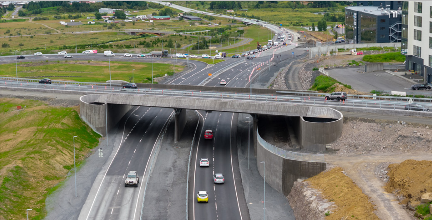
Nýja brúin yfir Breiðholtsbraut eftir að opnað var fyrir umferð. Myndir: Vilhelm Gunnarsson.
